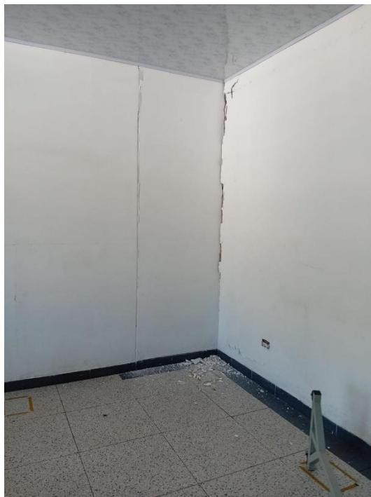
Ilustración 22. Columnas en cuarto piso
