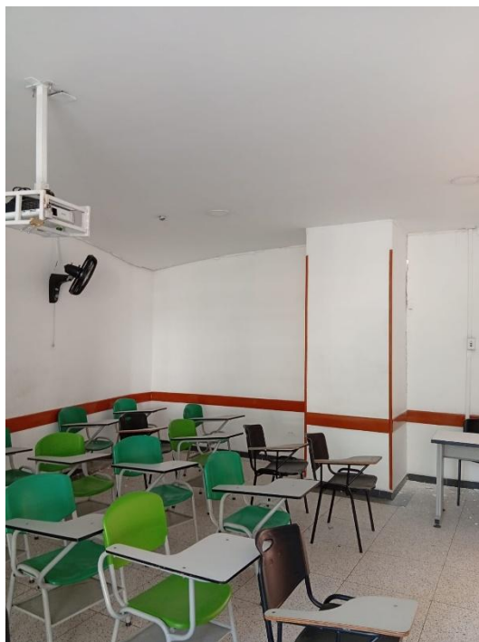
Ilustración 10. Columna segundo piso
