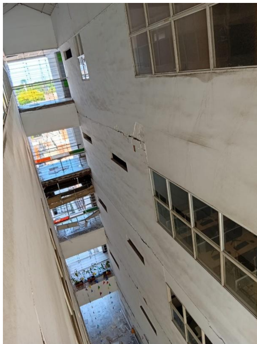
Ilustración 31. Vigas de entrepiso vista de 5to piso
