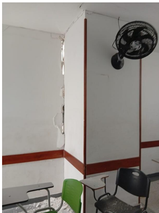
Ilustración 39. Detalle de muro en mampostería junta con columna
