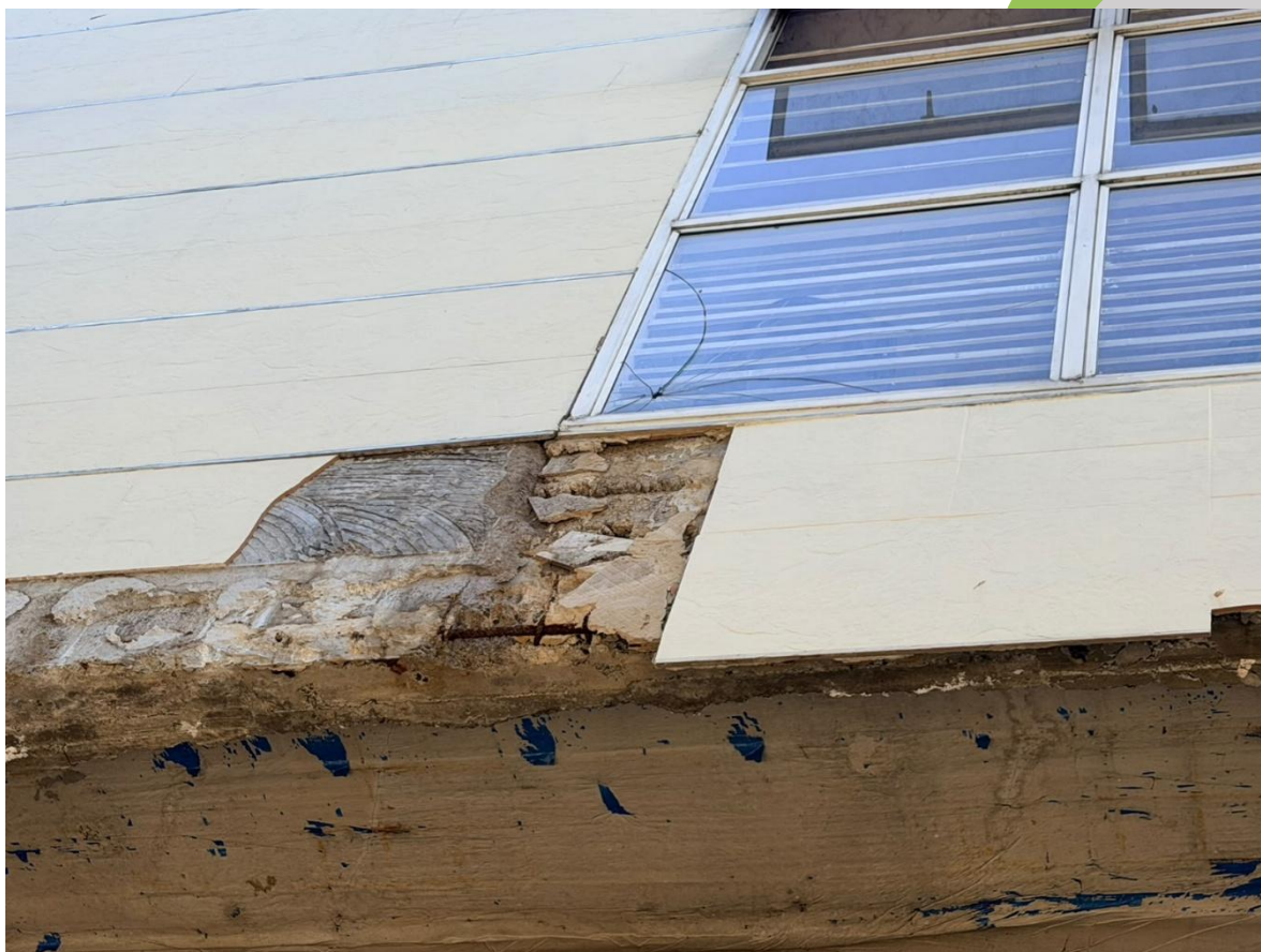
Ilustración 9. Losa de entrepiso piso 1 INTENALCO 10-08-2026
