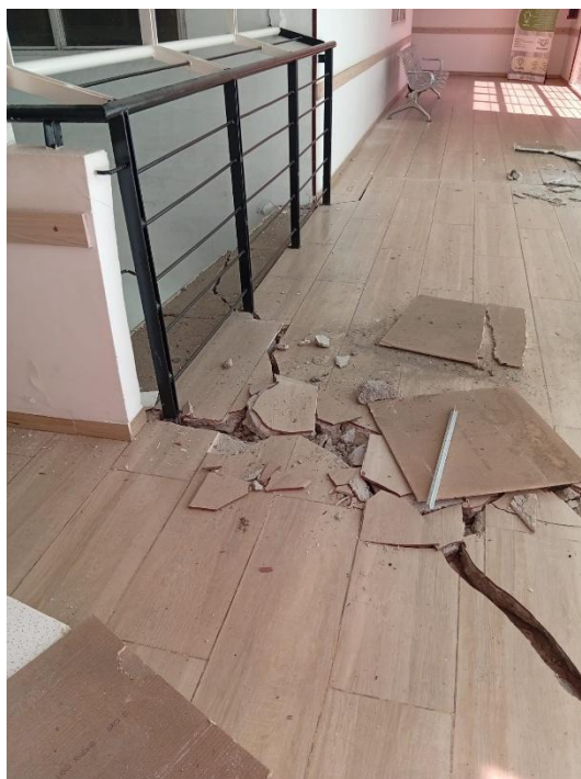
Ilustración 33. Zona de conexión entre los dos módulos piso 5
