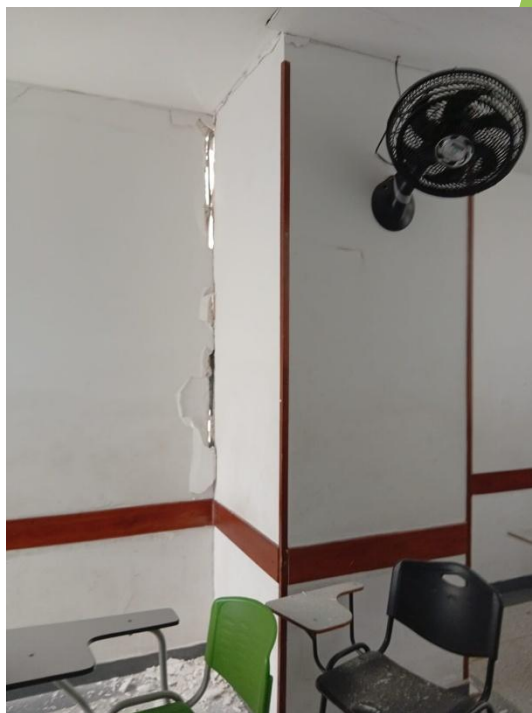
Ilustración 15. Columnas en piso 3
