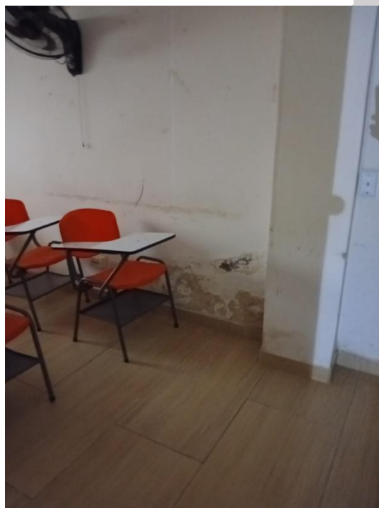
Ilustración 6. Columna dentro de la estructura
